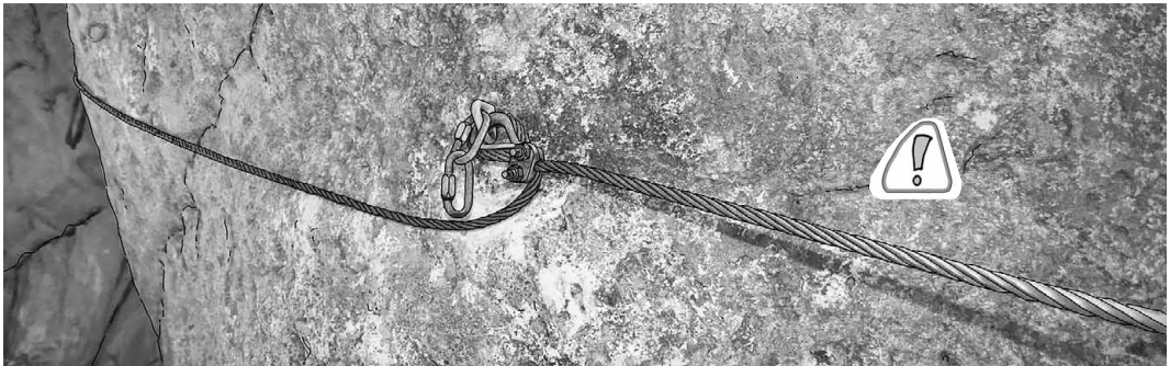
Main courante en câble inoxydable installée dans la partie haute du canyon des Ecouges.
