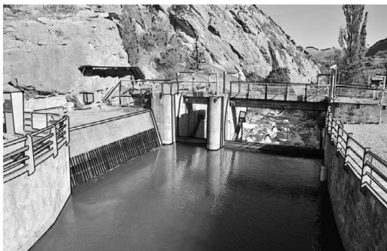
Bassin de rétention et prise d'eau du barrage situé en amont du canyon du Gourfouran (05)
