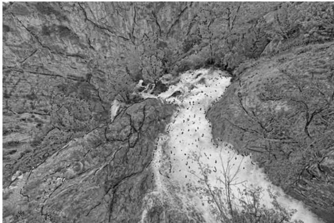
Débordement du bassin d'alimentation des conduites forcées du barrage situé sur le torrent de la Biaysse. L'eau se jette dans le canyon du Gourfouran (05)
