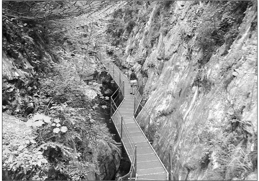
ILLUSTRATION 6 : Des visiteurs circulent sur les 1 500 mètres de passerelle installés, un filet métallique, visible dans le coin supérieur gauche de la photographie, protège l'ensemble du parcours d'éventuelles chutes de pierres (photo : André Suchet).
