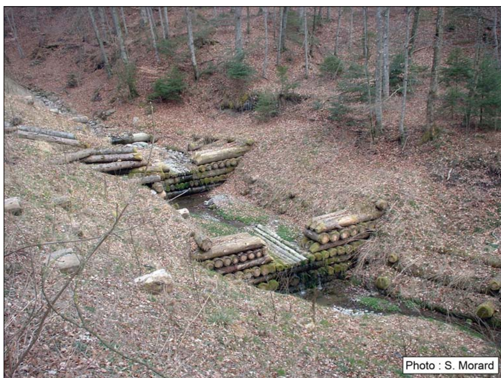
Fig. 4 – Seuils artificiels dans un torrent (Fribourg).
