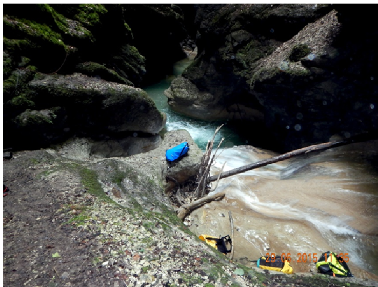
Figure 10 : Embâcle qui obstrue partiellement le cours d'eau. Sur la rive gauche, une amorce de dépôts témoigne de l'installation récente de l'obstacle.
