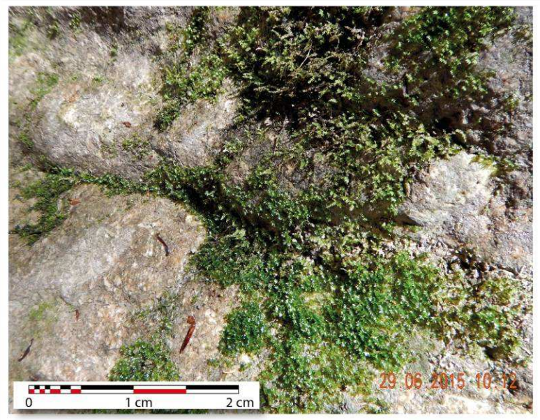
Figure 11 installations des mousses sur les parois au-dessus de l'eau.
