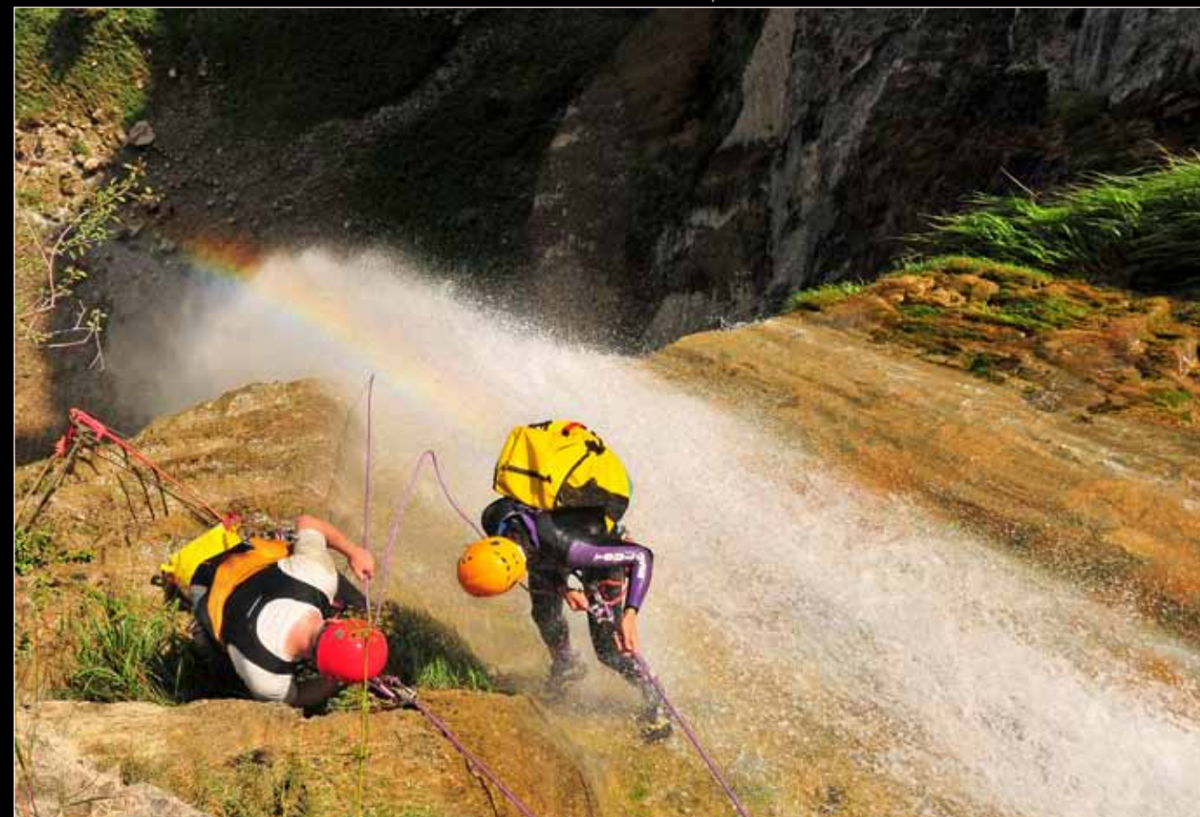
Cascade de Craponoz sur la commune de Bernin (Isère). Opération de rééquipement (FFME/FFS/FFCAM) en préalable au rassemblement interfédéral de 2008. © Olivier Gola
