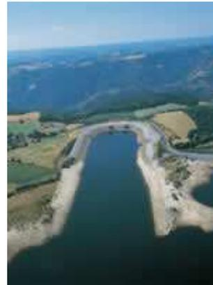
Ce type de barrage a été choisi en raison de la grande dimension des ouvrages et de la présence sur place d'une carrière contenant les matériaux nécessaires à leur réalisation. La centrale souterraine (A) est reliée aux deux réservoirs par des galeries (B). Cette usine puissante et fiable peut mettre 900 MW à disposition sur le réseau en 2 minutes, soit l'équivalent d'une tranche nucléaire.
